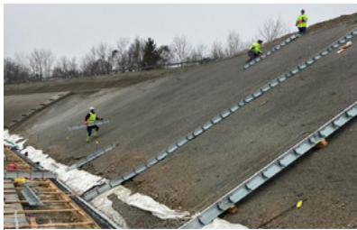
Kraftwerk Töging-Jettenbach, Deutschland
