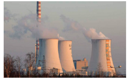
Kraftwerk in Jaworzno, Polen
